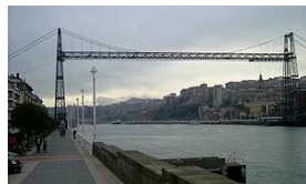
Puente Colgante de Vizcaya.
