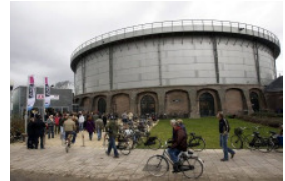
Tanque de almacenamiento rehailitado de la Westfabriek.
