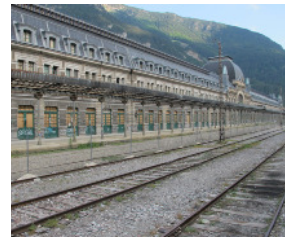
Imágenes exteriores de la estación de Canfranc.
