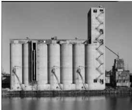
Fotografía de los silos americanos presentada por Walter Gropius en su conferencia Monumentale Kunst und Industriebau .
