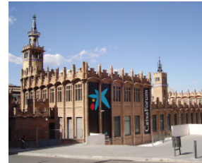
CaixaForum Barcelona. Aspecto exterior tras la rehabilitación de Roberto Luna.
