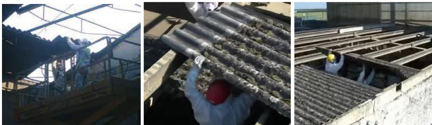
Figura 4. Retirada y manipulación placas fibrocemento (Calleja, A., Hernández, S. y Freixa, A. NTP 862: Orientaciones básicas de demolición, retirada o mantenimiento: ejemplos prácticos. INSST. 2010.)
