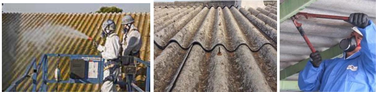
Humectación y encapsulado de las placas de fibrocemento y desmontaje de los anclajes de las placas de la cubierta.
