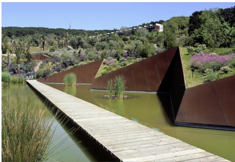
Detalle de muros de tierra armada de los intersticios de la malla.
