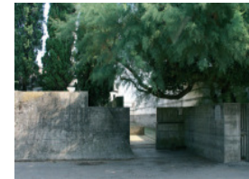
Acceso a la Tumba Brion por el recorrido "bajo", desde la calle
