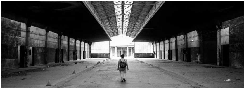
Figura 2. Edificio en el estado de abandono.
