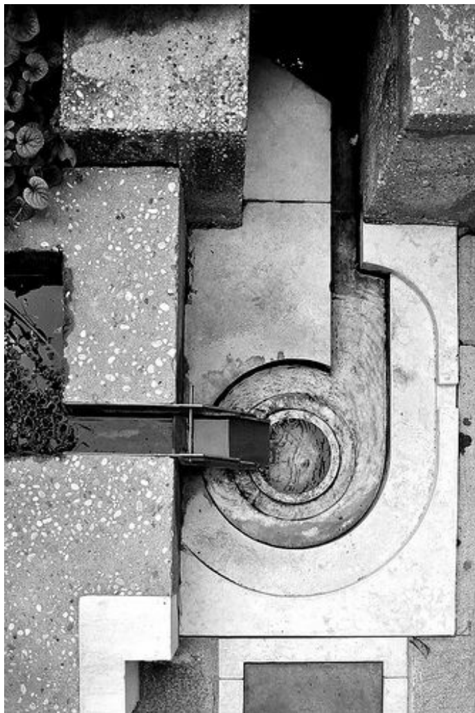
Detalle canalización de agua, Fondazione Querini Stampalia; Carlo Scarpa, Venecia. (1949).
