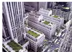
Figura 11 Estado actual de las cubiertas del Rockefeller Center
