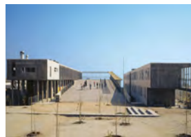
Figura 25 Cubierta urbana entre los prismas de uso docente del Colegio Altamira
