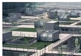
Figura 24 Vista de los diferentes elementos que forman la cubierta de la Universidad
