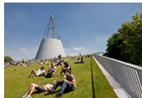
Figura 22 Personas sobre la cubierta de la Biblioteca de Delft
