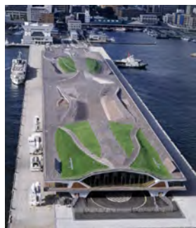
Figura 26 Vista aérea de la Terminal de Yokohama
