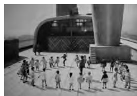
Figura 14 La azotea y el cielo de la Unité d’habitation de Marseille (1946-52)
