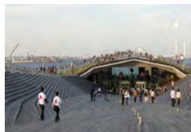
Figura 27 Cubierta urbana transitable con accesos al interior de la Terminal de cruceros
