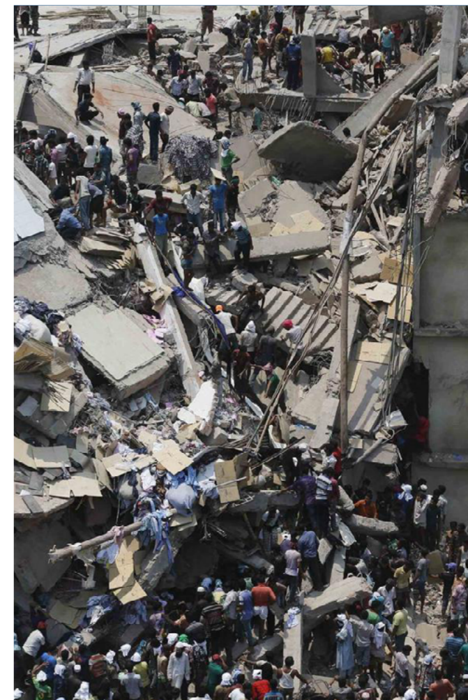
10. Derrumbe del edificio Rana Plaza
