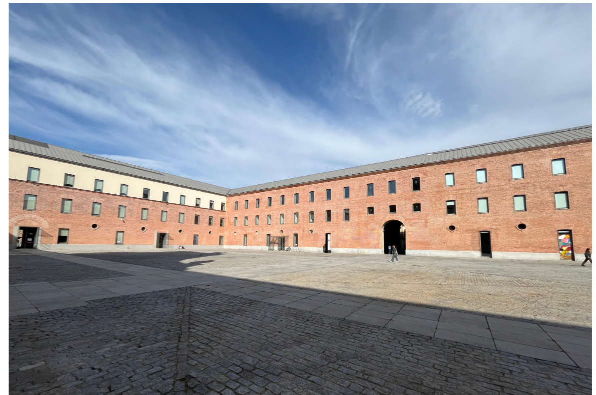
Figura 82, Patio central Conde Duque, vista lateral. Fuente: Elaboración propia, 2025
