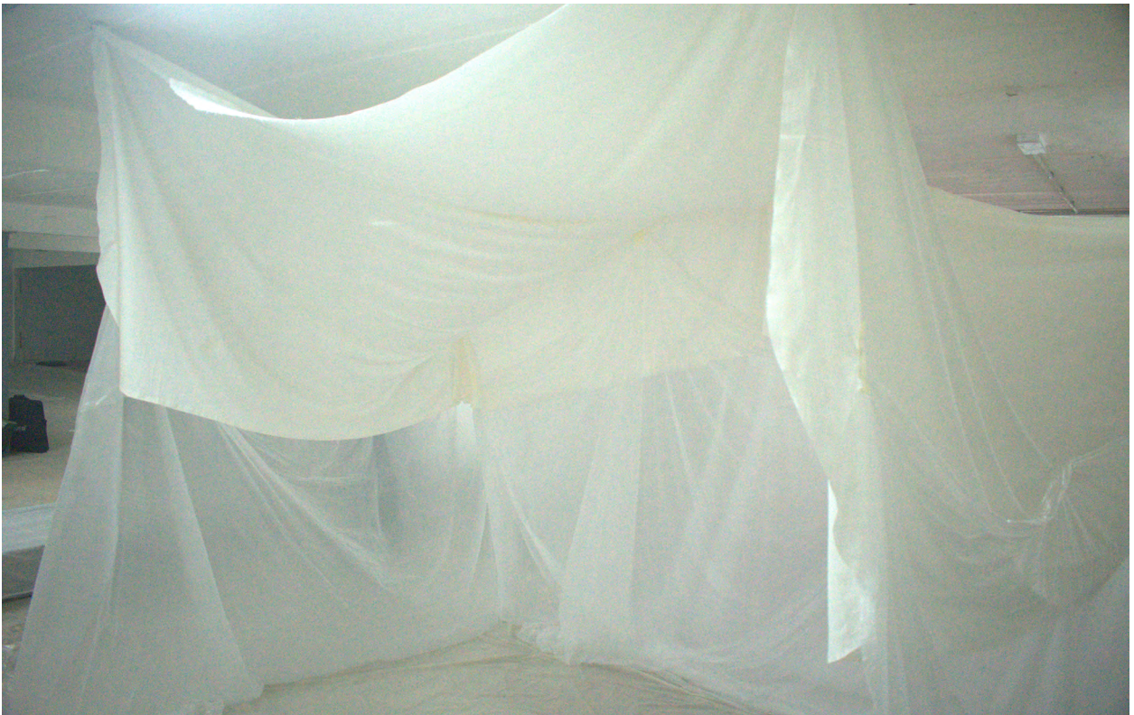
Fig. 87. Proceso montaje de cúpula
