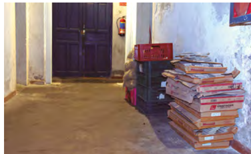
Figura 2.1-17. Cajas acumuladas en el pasillo de los almacenes. (Fuente: elaboración propia).
