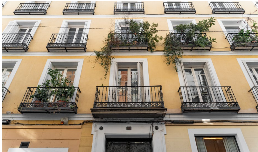
Fachada del edificio de la galería Juana de Aizpuru. La galería ocupa la primera planta. Fotografía tomada en la calle Barquillo, 44 (Madrid) el día 14/01/2022
