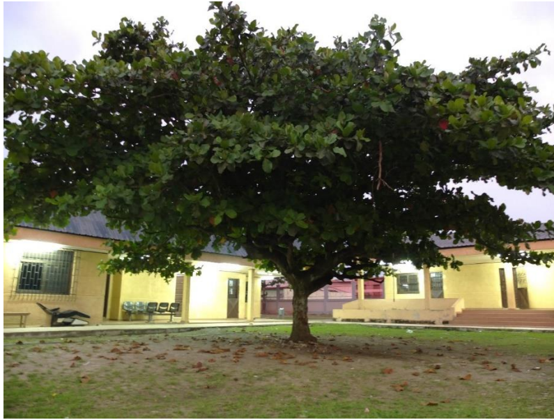
Imagen 14: El centro de Salud en Bata. A la derecha de la imagen, al fondo, el laboratorio. En el centro una gran ceiba preside el patio central. A la izquierda, entrada a dos consultas.
