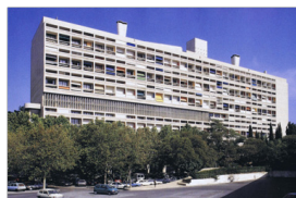
Fachada Unidad de Habitación de Marsella, Le Corbusier, 1952
