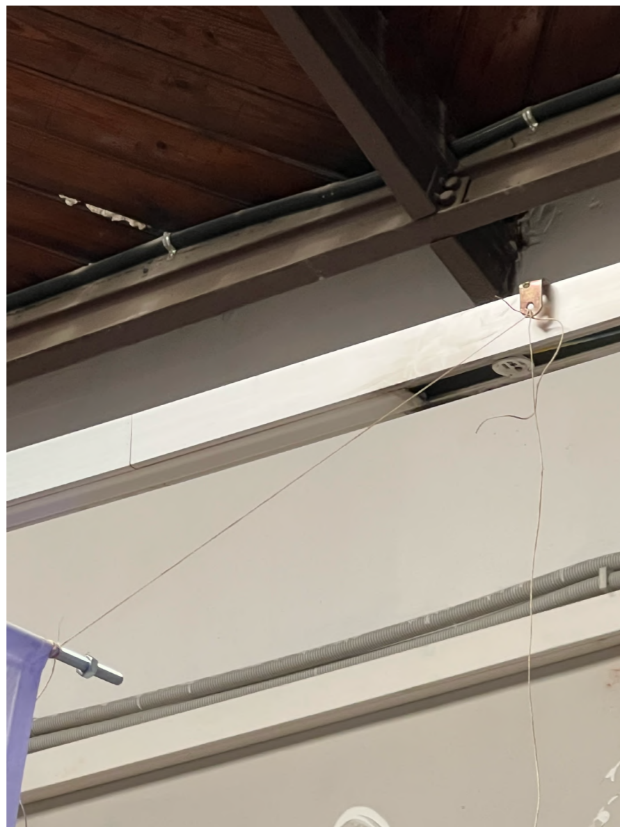
Fig 149. Detalle de montaje. Enganche para proyección
