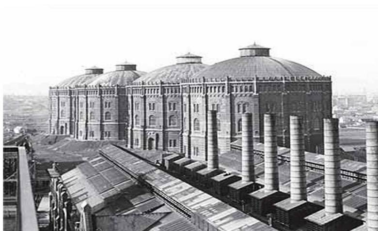
Gasómetros en área industrial
