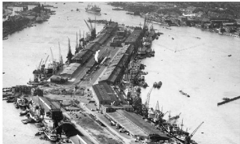
Eastern Docklands antes de la renovación
